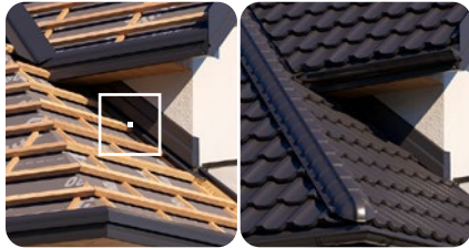
Wiatrownica wewnętrzna WW 83 L/P 1200x83 mm
