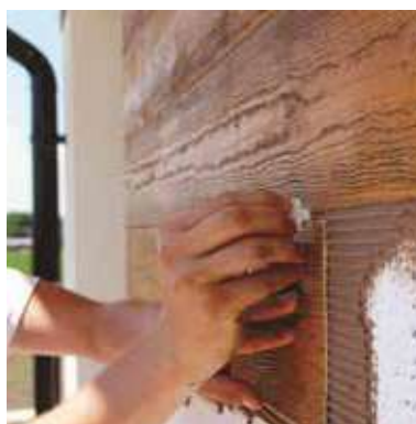
6. Za pomocą krzyżyka do glazury ustaw szerokość fugi.
