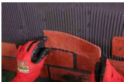
4. Przyklej elastyczną płytkę KLINKIERO.
