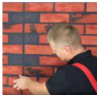
7. Przyklej pojedyncze płytki KLINKIERO na styku paneli lub rolek okładziny.
