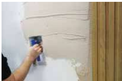
1. Za pomocą pacy zębatej 4 mm nanieś klej dyspersyjny Termolep-D.
