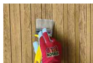
6. Zabezpiecz powłokę impregnatem.
