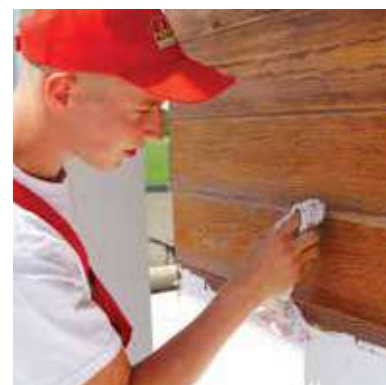
7. Mokrą szmatką owiniętą wokół palca zbierz nadmiar kleju, jednocześnie formując półokrągłe wgłębienie w fudze.
