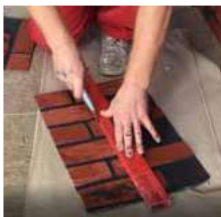
5. W razie potrzeby za pomocą nożyka przytnij odmierzony odcinek panelu KLINKIERO.
