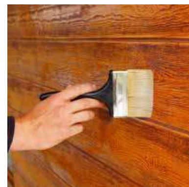
9. Zabezpiecz powłokę impregnatem.
