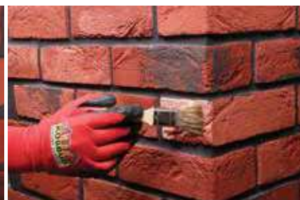
6. Po wyschnięciu kleju zaimpregnuj płytki impregnatem zabezpieczającym.
