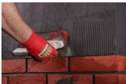
1. Za pomocą pacy zębatej 4-6 mm nanieś klej dyspersyjny TERMOLEP-D.
