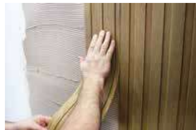
3. Przyklej okładzinę lamelową TABULO.
