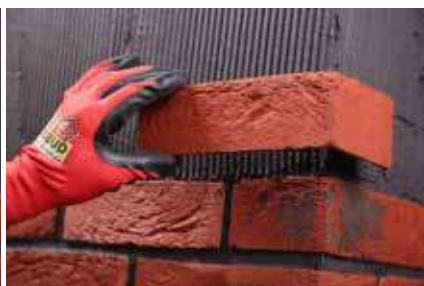
2. Przyklej płytkę KLINKIERO.
