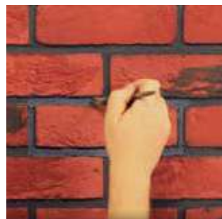
8. Za pomocą małego zwilżonego pędzla wykonaj fugi.
