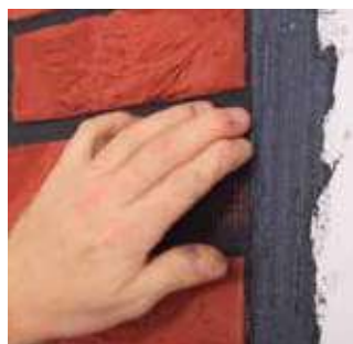
6. Wypchnij klej spod okładziny.
