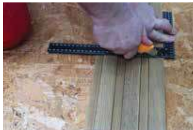
2. Przy pomocy kąta utnij odmierzone odcinek okładziny lamelowej TABULO.
