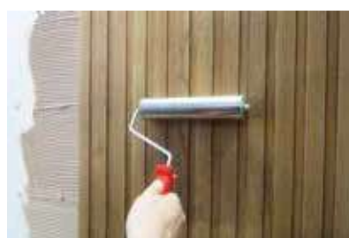
5. Twardym wałkiem do tapet dociśnij okładzinę, dokładnie wypychając wszelkie pęcherze powietrza.
