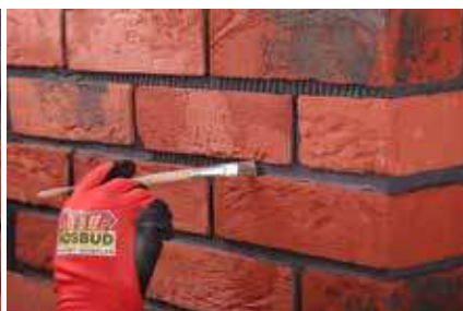
5. Używając zwilżonego małego pędzelka wykonaj fugi.
