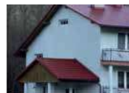
elewacja z powłoką mikroochronną KOSBUDPROTECT
