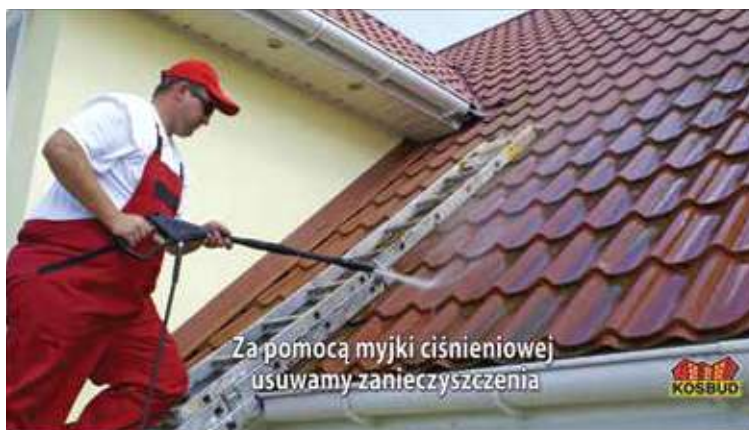
BIOLIT - środek do usuwania grzybów i porostów - Czyszczenie dachu z glonów
