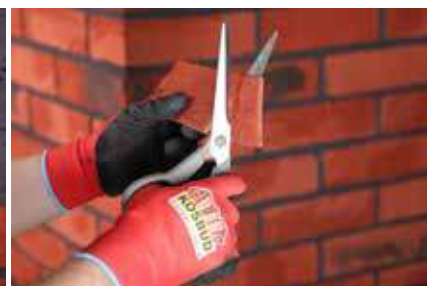
3. Utnij nożyczkami odmierzony odcinek płytki KLINKIERO.
