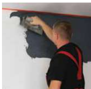
2. Nałóż klej TERMOLÉP-D za pomocą pacy 4-6 mm.
