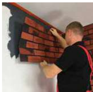
3. Przyklej elastyczny płaski panel KLINKIERO...
